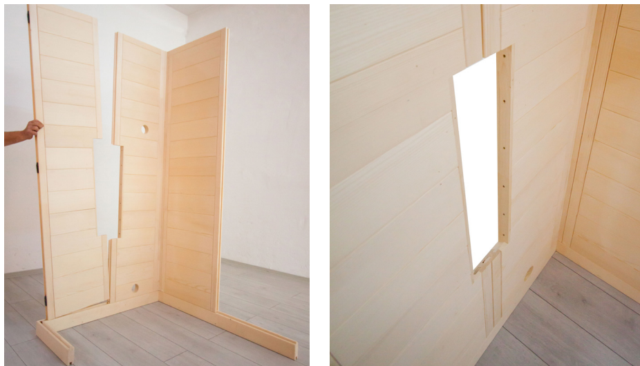
Fig. 6: Inserimento dell'elemento parete con intaglio
