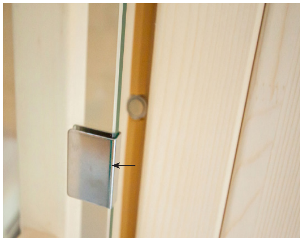
Fig. 35 : Montage de la tôle extérieure
