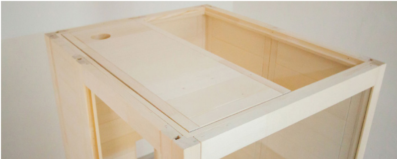
Afb. 14: Plaatsen van dakelementen voorzijde
