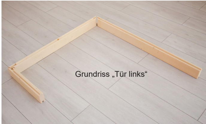
Abb. 1: Auflegen der drei Bodenrahmen-Elemente
