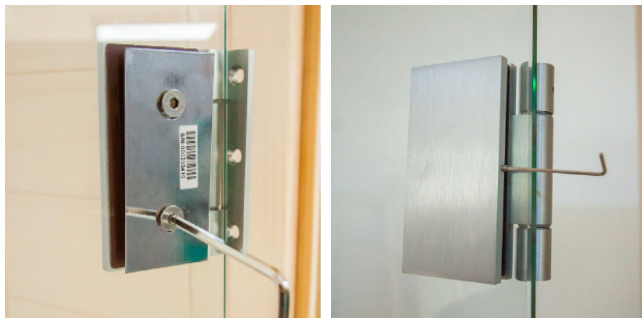
Fig. 32 : Montage des ferrures de portes 2
