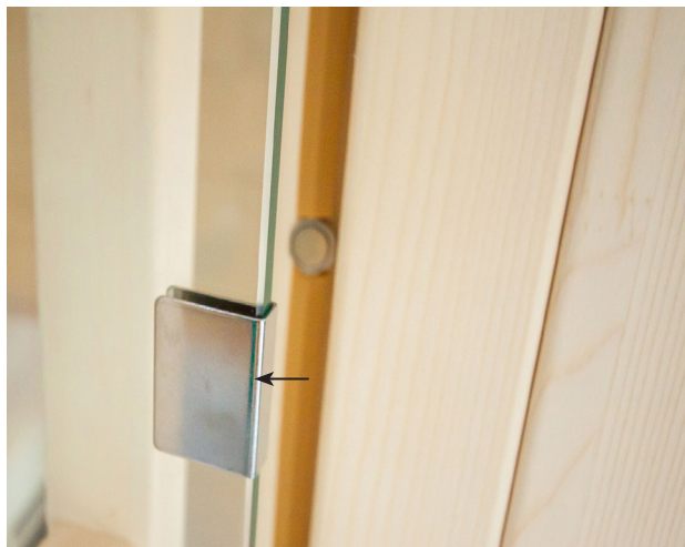
Fig. 35: Montaggio della piastra a scorrimento
