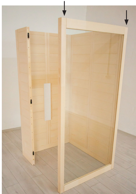
Abb. 10: Montage des Türrahmens
