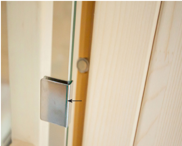
Abb. 35: Montage Überschub-Blech
