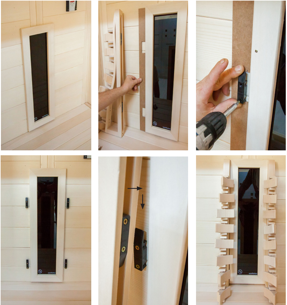
Abb. 29: Montage Rückenlehnen
