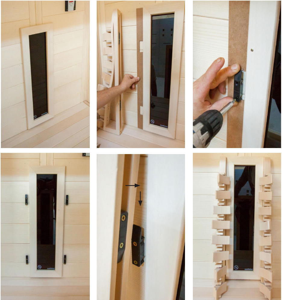
Fig. 29: Montagem dos encostos
